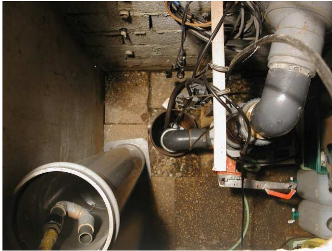
Vue du forage de 300mm
