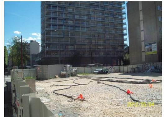
Fig. 1 : Exemple de dépollution des sols sur le site d'une ancienne station service !
