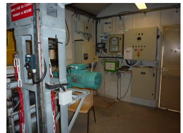
Fig. 2 : à l'intérieur : au premier plan la motorisation de la traîlle, en arrière plan armoire de surveillance et de contrôle
